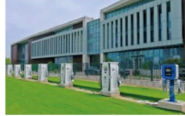
■ 杭州萧山直流配电项目
