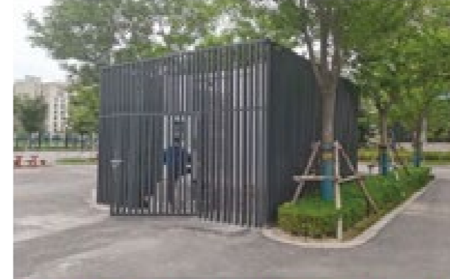
■ 隆基交大创新港光储充微网项目
