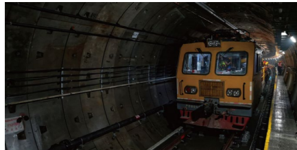
■ 隧道内电动工程车辆施工
