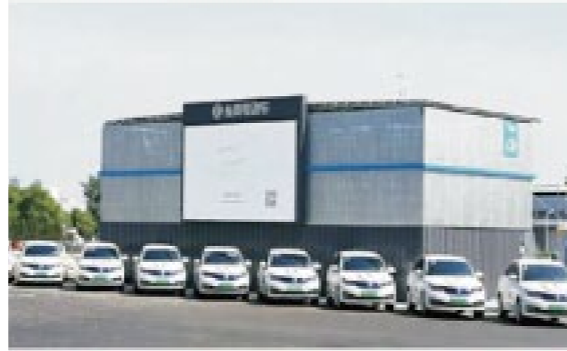
■ 东风汽车立体车库微电网项目
