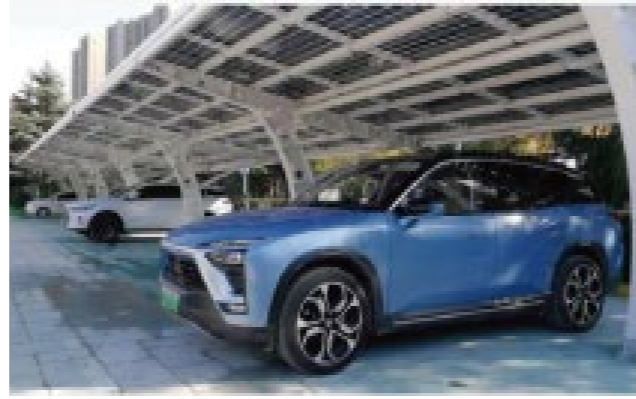
■ 西电集团微电网项目
