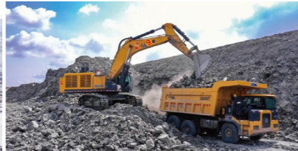
■ 矿区电动工程车辆施工
